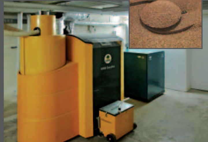
Holzzentralheizung (Pelletsheizung)
