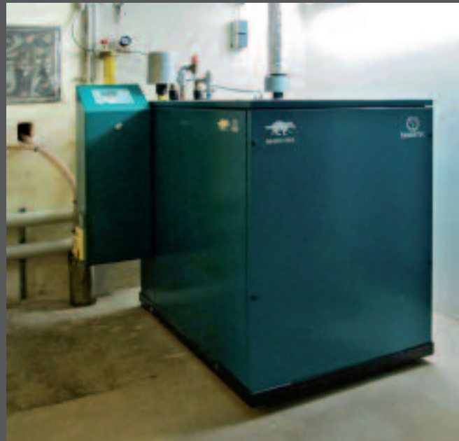
Kraft-Wärme-Koppelung (Mini-BHKW)
