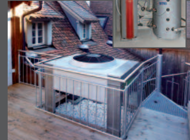
Splitverdampfer einer Luft-Wasser-Wärmepumpe
