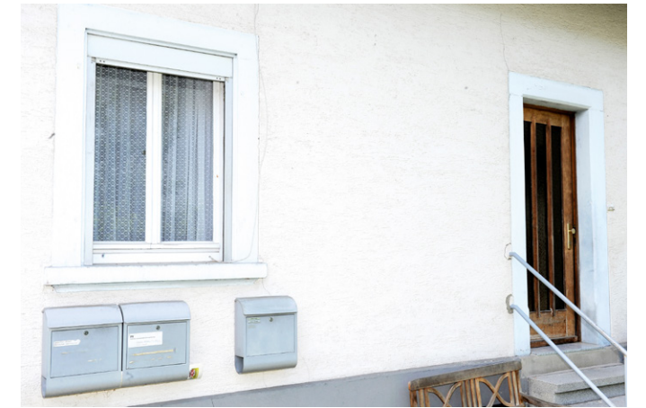
Ganzheitlich sanieren: Wird die Fassade erneuert, ...
