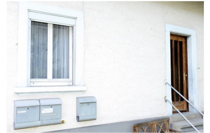
Ganzheitlich sanieren: Wird die Fassade erneuert, ...
