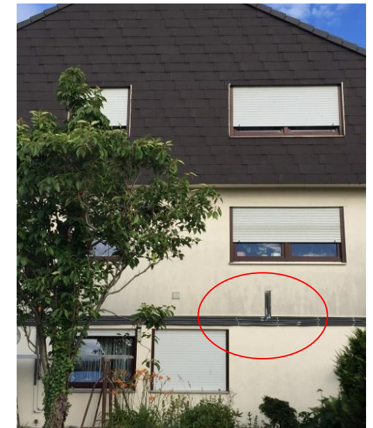
Beispiel: außenliegende Heizrohre
