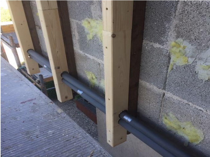
Heizungsinfrastruktur In der Einblasdämmung
