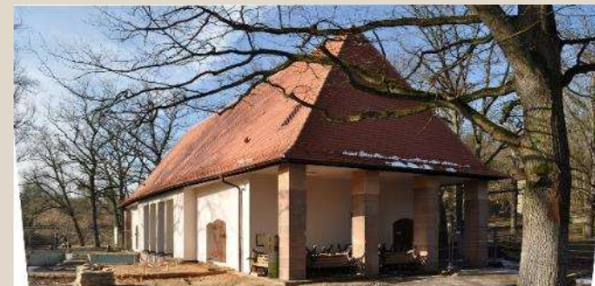
Sanierung und Umnutzung Wüstenhaus (2016-2018)
