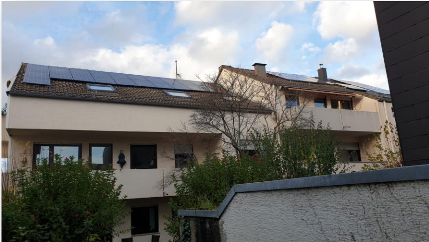
Quelle: Berner Elektrotechnik GmbH
