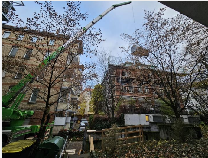
Quelle: Berner Elektrotechnik GmbH
