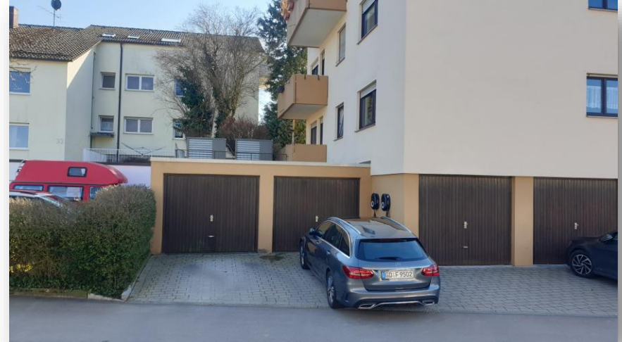
Quelle: Berner Elektrotechnik GmbH
